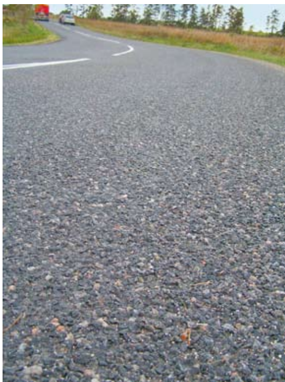
Teststrecke Hjollundvej, Dänemark
